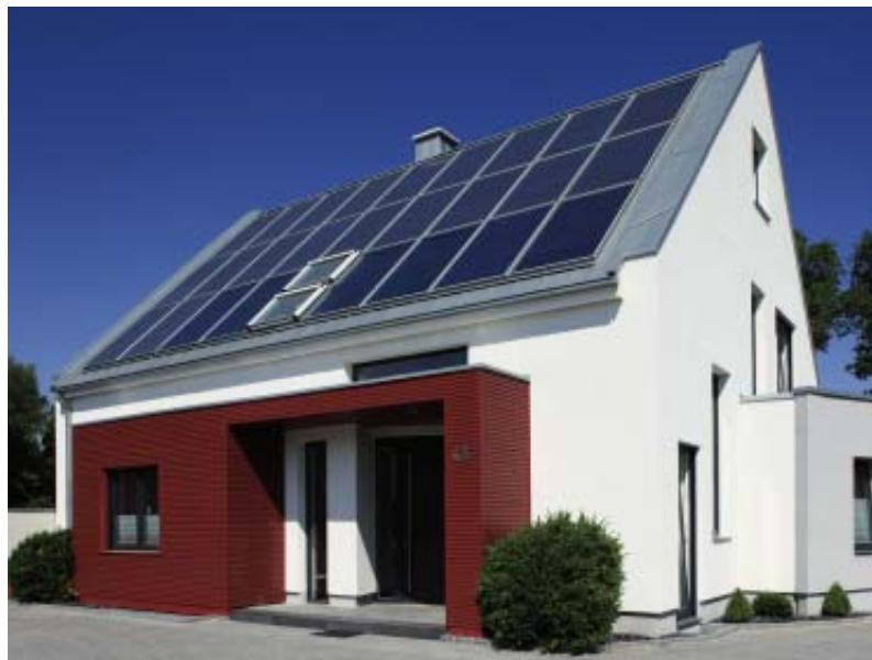
Solarthermieanlage mit Wärmepumpe und Photovoltaik für echte Unabhängigkeit von Öl oder Gas
