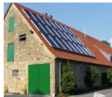
Landwirtschaftlicher Betrieb mit Aufdachmontage
