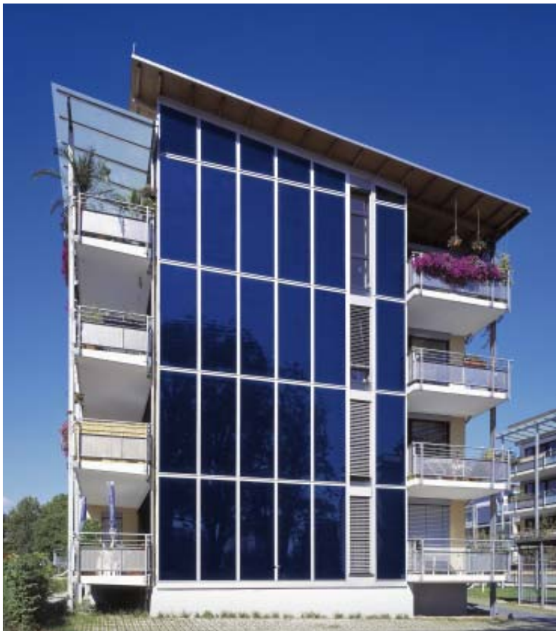
Mehrfamilienhaus mit Fassadenmontage
