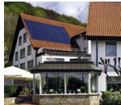
Hotel mit Indachmontage
