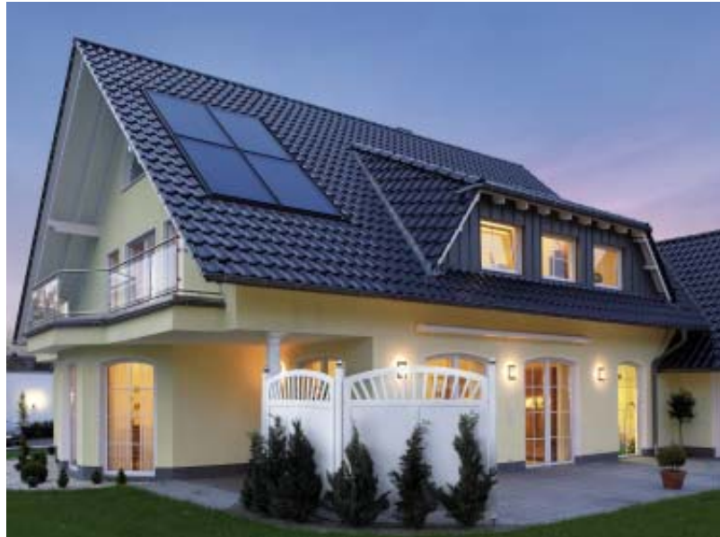
Solarthermieanlage zur Heizungsunterstützung
